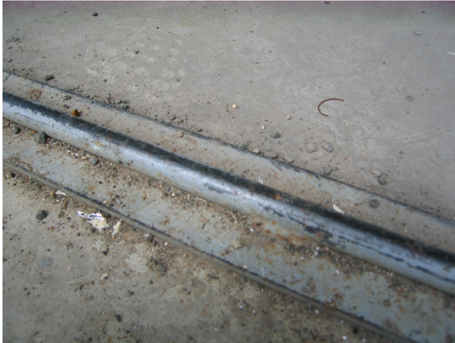
Fotografia della guida inferiore, ove è stato riscontrato un possibile punto di inciampo
