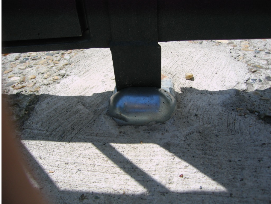
Fotografia della battuta centrale, ove è stato riscontrato un possibile punto di inciampo
