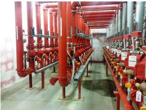
**A umido:** le tubazioni sono costantemente tenute piene d'acqua e l'intervento sarà localizzato a seguito della rottura di una o più testine sprinkler quando la temperatura si innalzerà a causa dell'incendio. L'area interessata sarà
