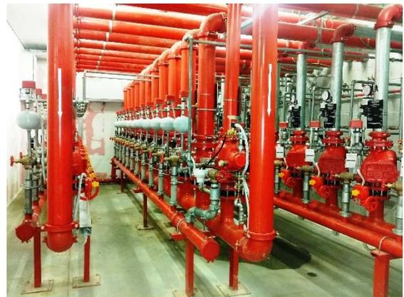
**A preazione:** le tubazioni sono piene d'aria, a bassa pressione, avendo il compito di sorvegliarne l'integrità. Utilizza un sistema di rivelazione incendio che comanda la valvola di controllo.
